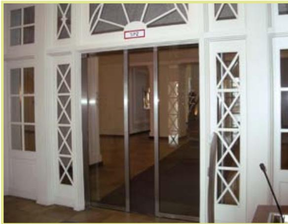
Außerhalb der Geschäftszeiten könnten diese Türanlagen aber auch zusätzlich durch geprüfte einbruchhemmende (Drehflügel-) Türen oder Rollläden gesichert werden. Auch hier sollte grundsätzlich eine Montage hinter der Türanlage bevorzugt werden.
