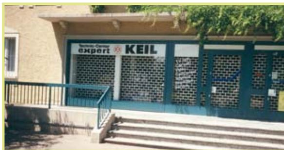
Sicherung mit innenliegendem Rollgitter
